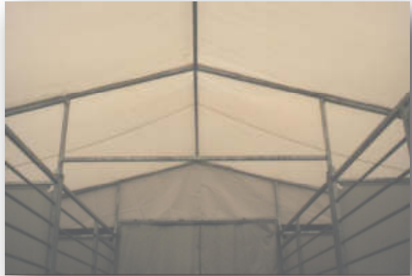
Variable Mietboxen mit Stallgasse und mehrteiligem Planendach, Kederschiene und Dachkonstruktion mit Querstreben
