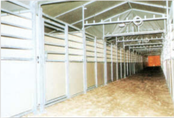
Variable Mietboxen mit Stallgasse und mehrteiligem Planendach, Kederschiene und Dachkonstruktion mit Querstreben
